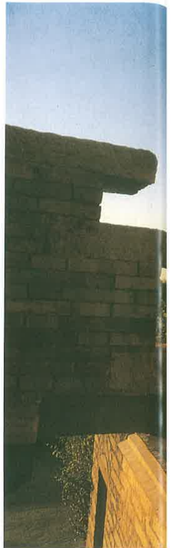
紅毛城主堡南側露台入口及雉堞，雉堞上壓石的遮簷。
